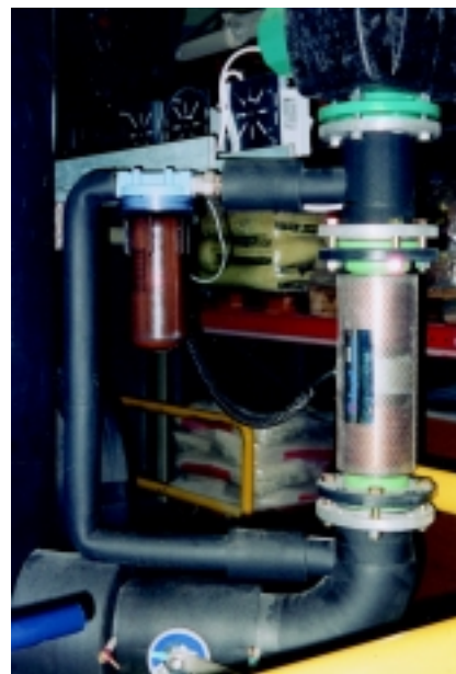
Bauer AK plastitööstuse jahutussüsteemis
