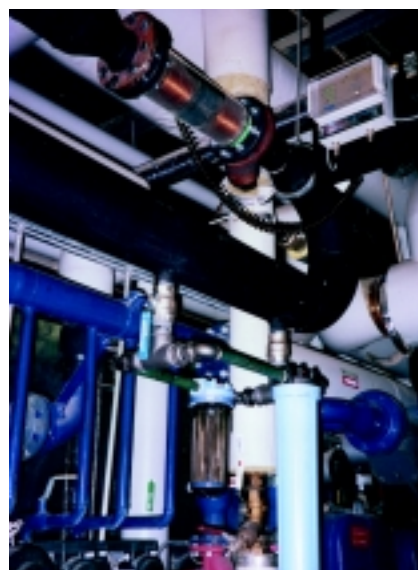
Bauer AK Viru Hotelli ventilatsiooni-küttesüsteemis
