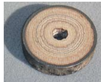
Katlakiviga täitunud 100 mm terasest soojaveetoru
