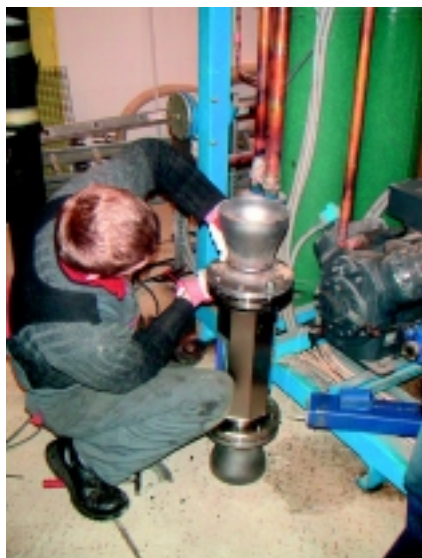
Bauer Pipeje® paigaldamine plastitööstusettevõtte veejahutussüsteemi
