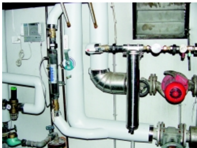
Bauer Pipeje® koos filtriga korteriühistu keskküttesüsteemis
