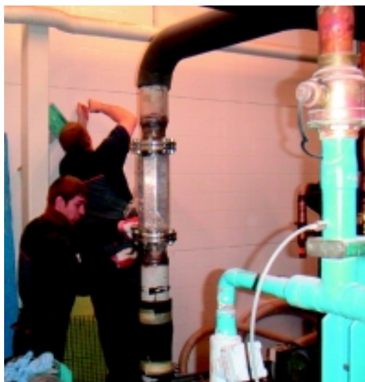
Bauer Pipeje® paigaldamine plastitööstusettevõtte veejahutussüsteemi
